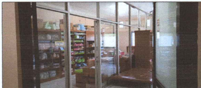
Pemasangan sekat satelit ICU
